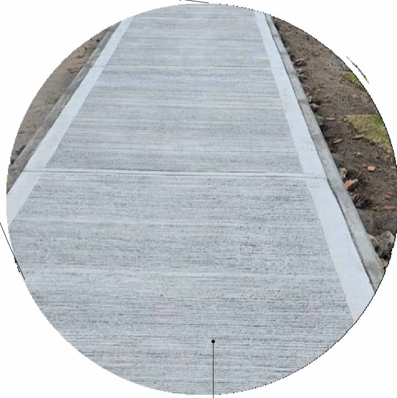
Calçada em concreto, desempenado, junta polida nas extremidades, juntas de dilatação a cada 1,5m.
